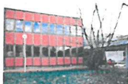
Nuovo Centro Civico Pozzo Strada in Torino
