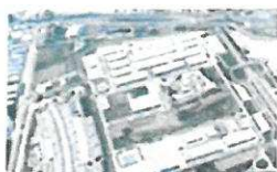
SITO : Interporto di Torino Infrastrutture varie
