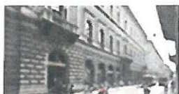
Palazzo Turati in Milano ristrutturazione e restauro
