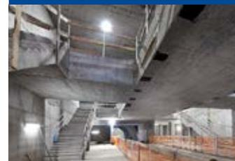
Sono terminati i lavori per la copertura del piano inferiore e le opere in cemento armato delle banchine (4+8). Per quanto concerne gli impianti meccanici, anche in questo cantiere sono stati approvvigionati gli ascensori di stazione.
